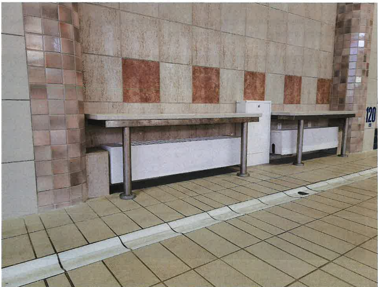
Wymieniono 13 sztuk grzejników płytowych wraz z zaworami na plaży basenowej
