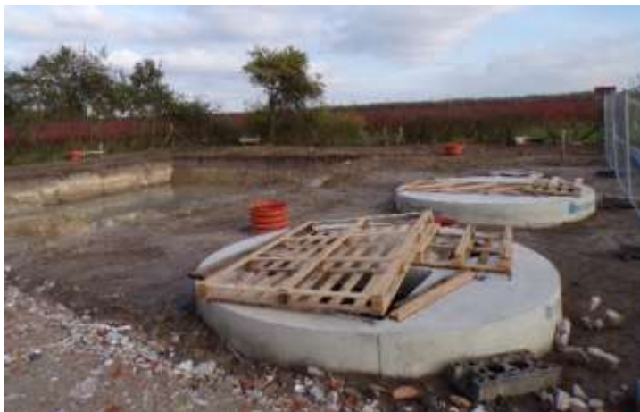
Budowa oczyszczalni ścieków w Nowej Wsi
