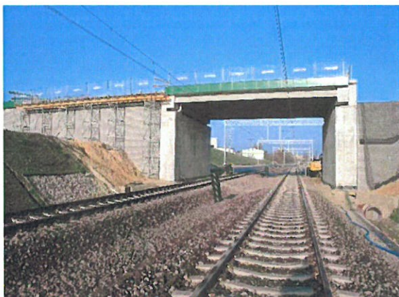
Warka ul. Lotników – Wiadukt
