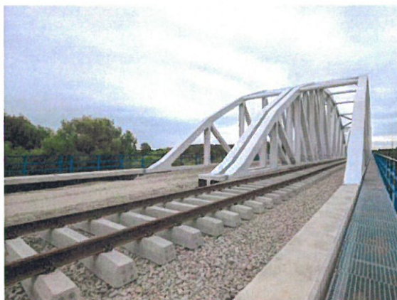
Most kolejowy na rzece Pilicy
